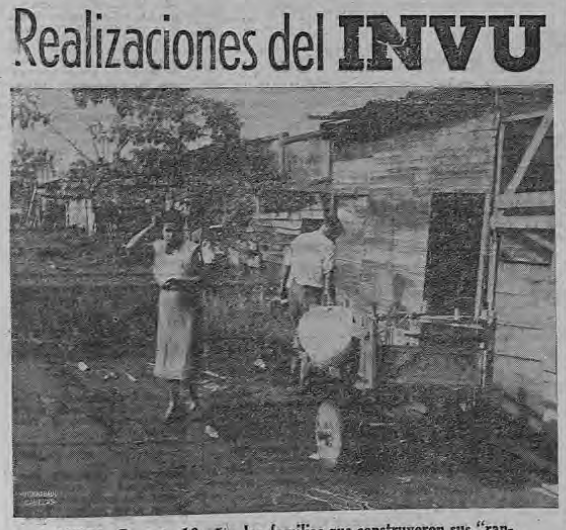
ANTES: Durante 10 años las familias que construyeron sus "ranchitos" recostados a las tapias del Reformatorio San Dimas, vivieron en situaciones higiénicas deplorables.
